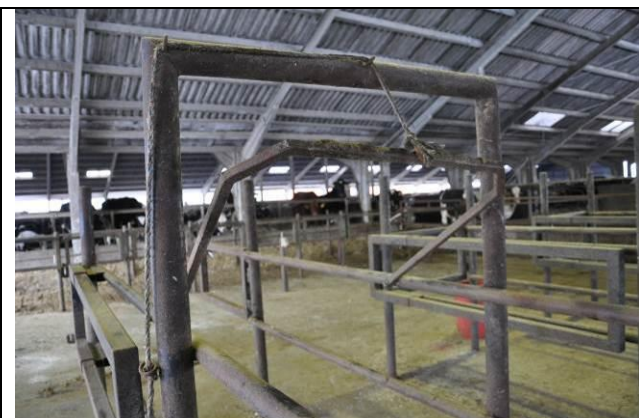
Figur x. "Fang-bøjlen" er oppe når koen går frem til lågen i drivgangen. "Fang-bøjlen" er hjemmelavet og fungerer fint ifølge kvægbrugeren.
