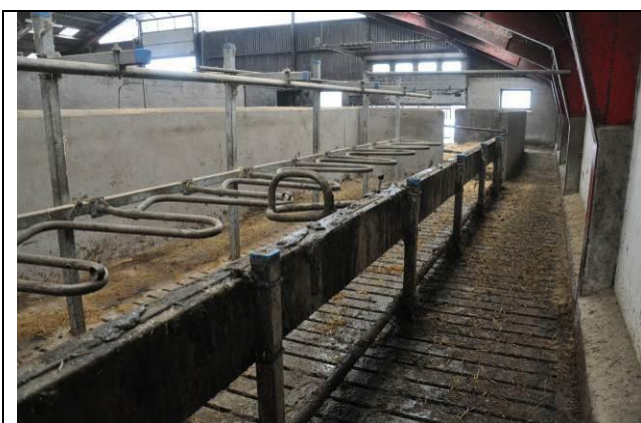
Figur x. En 1,1 meter bred arbejdsgang bag ved køerne. Kvægbrugeren vurderede at bagbommen sidder i en passende højde (overkant sidder 0,94 meter over ståsted).
