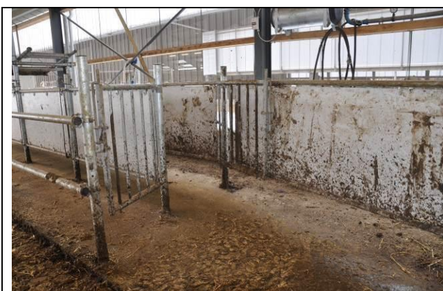
Figur x. Indgang til en meter bred drivgang som fører til klovbeskæringsboksen. En låge kan lukkes efter
