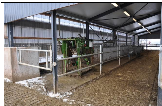
Figur x. Et kig ind i bygningens anden ende, med spalter på ædepladsen.
