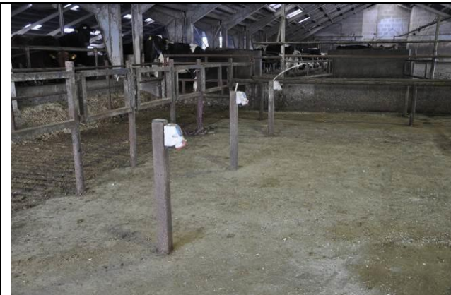
Figur x. Forenden af hver drivgang er der et 400 volt el-udtag til brug ved klovbeskæring.
