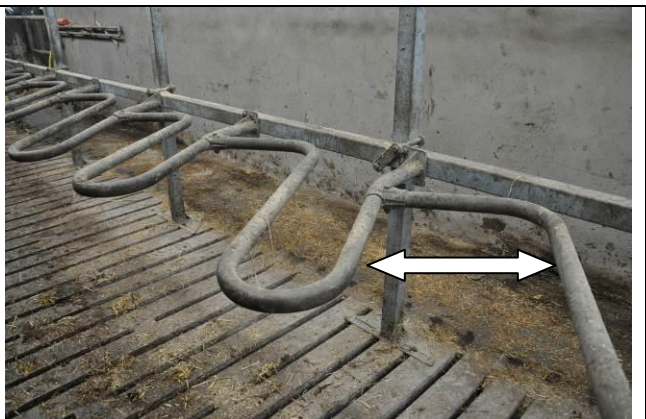
Figur x. Kopladsens indvendig mål er 0,44 meter.
