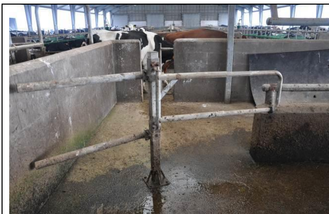
Figur x. En envejslåge kun til brug for personalet ved køernes indgang til behandlingsgangen er en god løsning, fordi den giver let og god plads for personalet til at passere på tværs af behandlingsgangsområdet.
